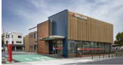
大田営業部の新築
